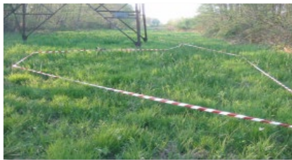
Balisage d'une station de plante protégée en préalable à des travaux sur pylône – Sologne – SCE 2014
