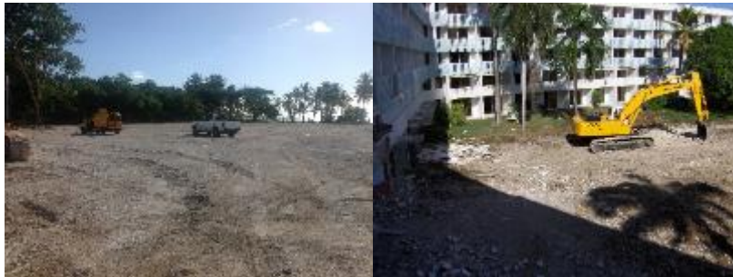
L'hôtel en cours de démolition en 2013
